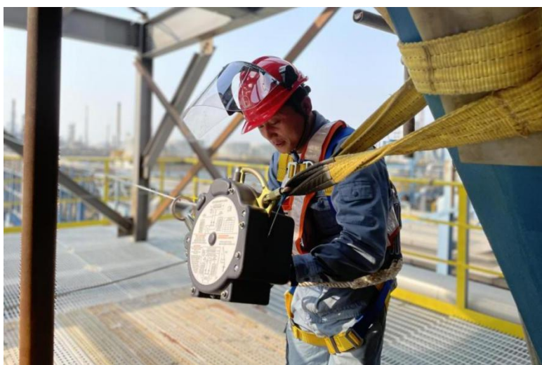
张阳在检查高处作业防护设施
